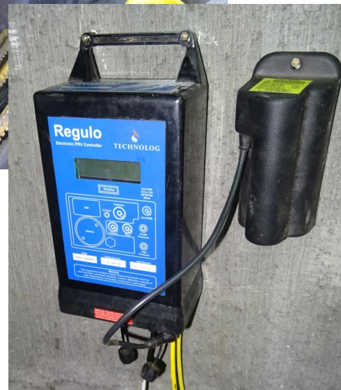
Strefa wodociągowa nr 11 przepływomierz elektromagnetyczny + reduktor ciśnienia + regulo
